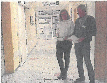
Der Boden im Erdgeschoss vom Eingang bis zum Treppenhaus soll erneuert werden.
