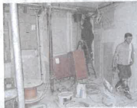
Der Eingangsbereich wird derzeit umgebaut.
